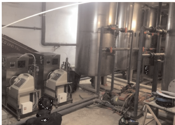
Hình 3. Hệ thống ozone xử lý nước sinh hoạt tại FLC Hạ Long [11]
