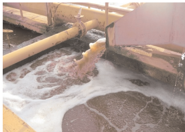
Hình 1. Lắp đặt vận hành hệ thống sục ozone xử lý nước thải ngành dệt may [9]
