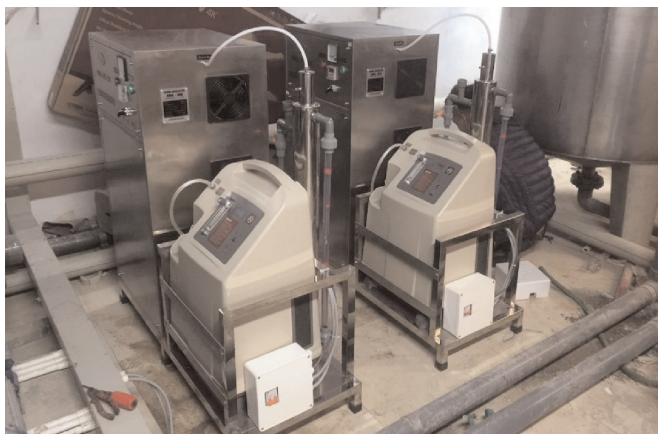
Hình 3. Hệ thống ozone xử lý nước sinh hoạt tại FLC Hạ Long [11]
