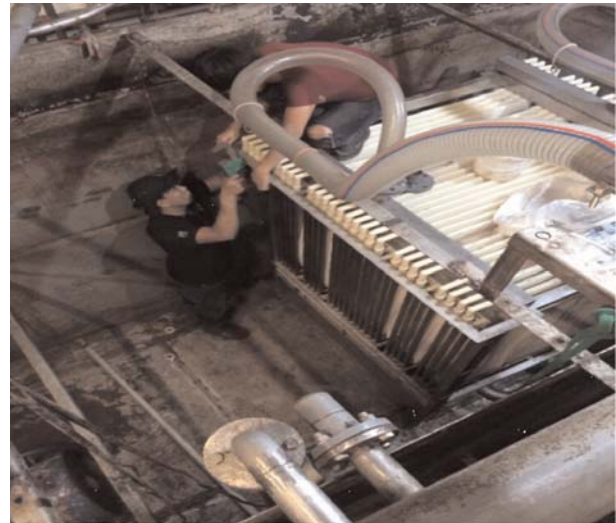
Hình 7. Hình ảnh lắp đặt và vận hành công nghệ MBR tại Khách sạn JW Marriott
