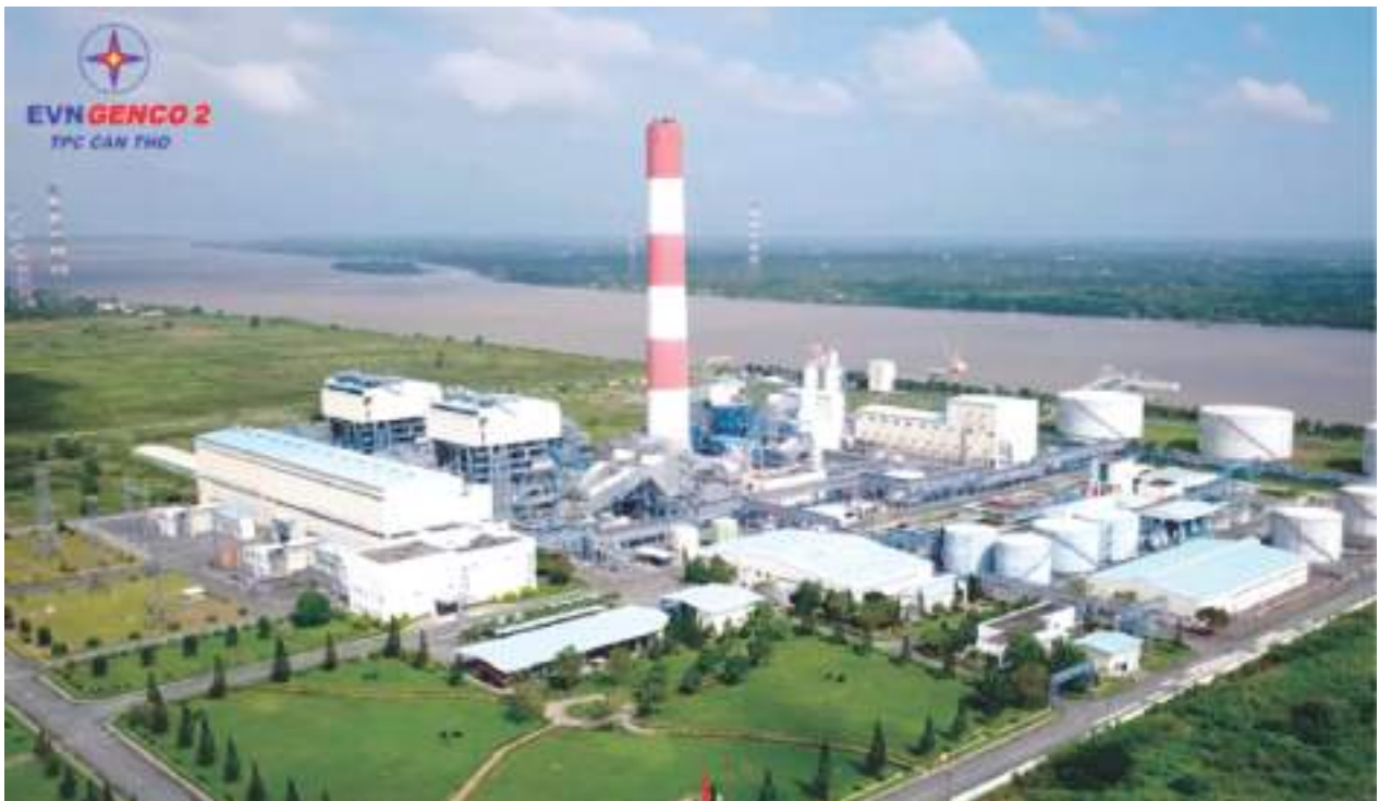
Trước mắt, EVNGENCO 2 sẽ tiến hành thí điểm số hóa 3D các thiết bị, hệ thống trong nhà máy Nhiệt điện Ô Môn, thuộc Công ty Nhiệt điện Cần Thơ.
