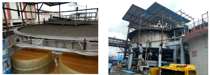
Krofta DAF ở nhà máy giấy kraft, Gayatri Shakti công suất 400 tấn/ngày
